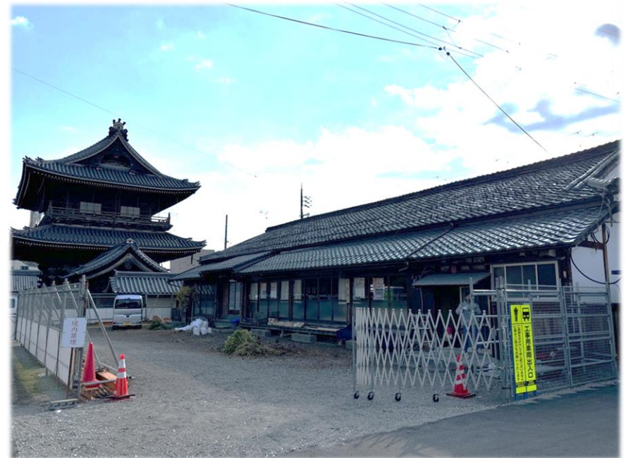
▲ 改修中の大通寺総会所
